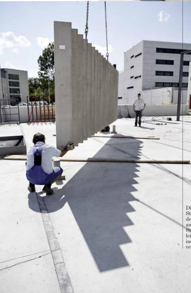
Die auf den Wangen liegenden Stahlbetonfertigteilstiegen wurden auf Stahlbetonfundamenten aufgelagert, der auskragende Stiegenlauf ist über Stahleinbauteile im unteren Lauf indirekt mit dem Fundament verschweisst.
