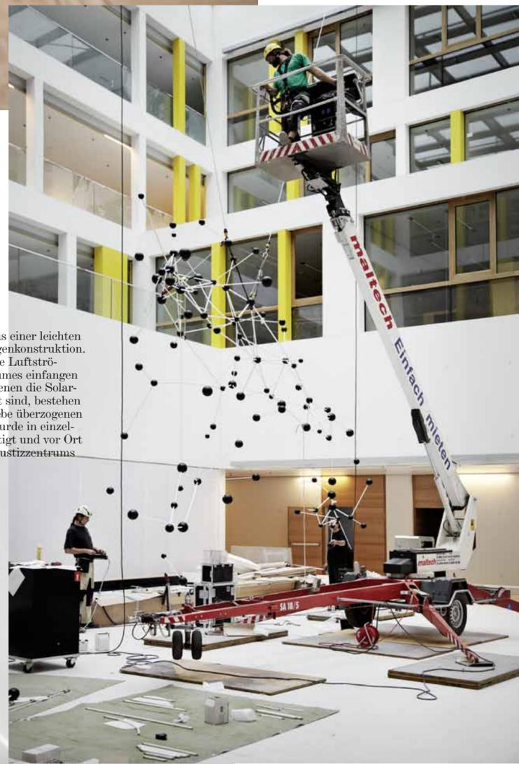
Libra besteht aus einer leichten Aluminiumstangenkonstruktion. Die Segel, die die Luftströmungen des Raumes einfangen sollen und auf denen die Solarpaneele montiert sind, bestehen aus mit Alugewebe überzogenen Ringen. Diese wurde in einzelnen Teilen gefertigt und vor Ort im Atrium des Justizzentrums montiert.
